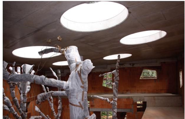
**Bild 10** Innenansicht eines Geheges im Rohbauzustand des massiven Gebäudes mit bereits eingebrachten Kletterbäumen für die Zootiere
