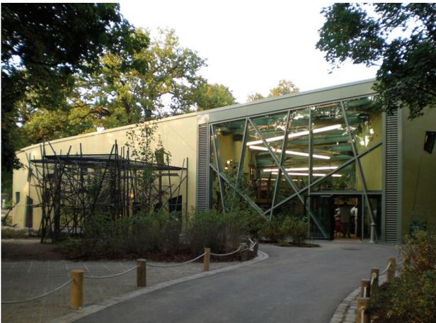
**Bild 2** „Prof.-Brandes-Haus“ mit Blick auf den seitlichen Eingang in den mit Stahl-Glas-Konstruktionen geschlossenen mittleren Gebäudeteil
