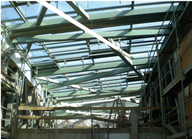
**Bild 9** Montage der Dachkonstruktion mit unregelmäßiger Struktur des Primärtragwerkes und der darüber befindlichen orthogonalen Sekundärstruktur zur Aufnahme der Verglasungselemente
