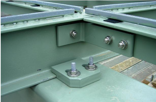
**Bild 12** Detail der Befestigung der Sekundärstruktur auf dem Primärtragwerk mit Knaggen
