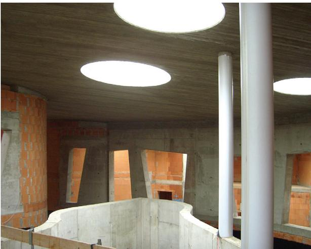
**Bild 11** Innenansicht im südlich gelegenen massiven Gebäudeteil mit großem Pflanzenbecken während der Bauausführung: Die Dachdecke hat zahlreiche kreisrunde Öffnungen. Der Wandbereich im Bildhintergrund ist als Stahlbetonrahmen ausgebildet worden.
