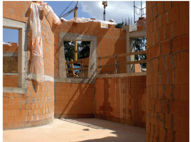
**Bild 5** Mauerwerksinnenwände mit integrierten Stahlbetonrahmen für die unregelmäßigen Fenster- und Türöffnungen
