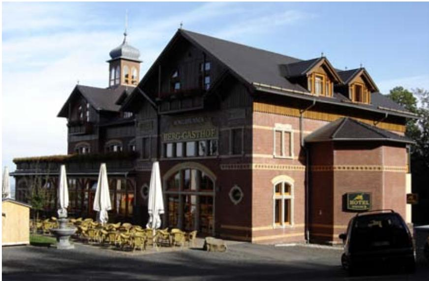
*Die Bestandskonstruktion des Gebäudes umfasste vor dem Wiederaufbau lediglich die Außenwände und die Decke über dem Kellergeschoss sowie einzelne Deckenträger.*
