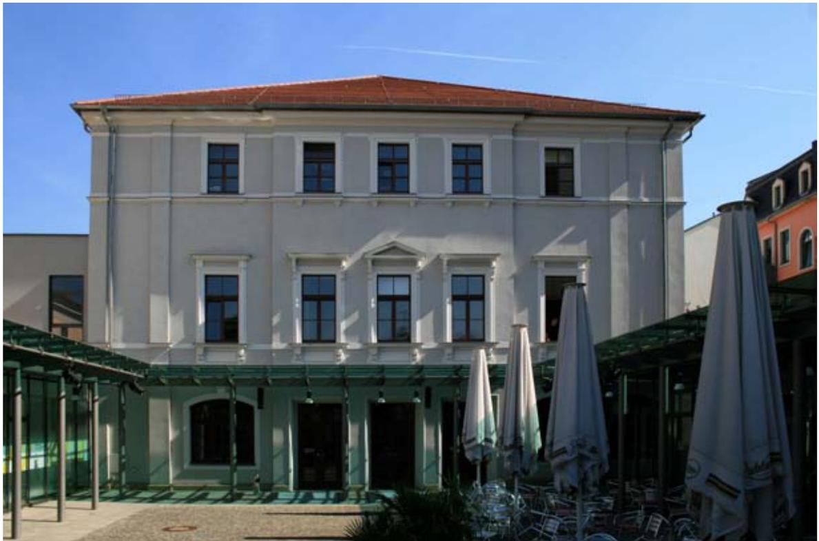
*Das unter Denkmalschutz gestellte Vorderhaus (Foyer) blieb in seiner äußeren Gestalt erhalten. Im Zuge der Umbaumaßnahmen wurden das Dach, die Decken über dem EG und dem 1. OG sowie die Innenwände mit Ausnahme der Treppenhauswände komplett abgebrochen und durch neue Konstruktionen ersetzt.*
