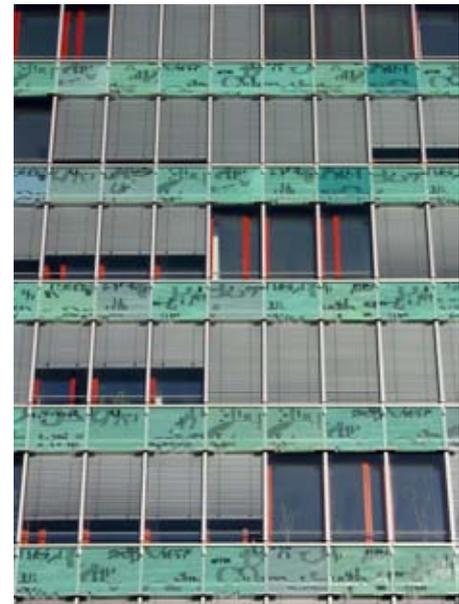
*Die Baumaßnahmen für das Hochhaus des Dresdner Druck- und Verlagshauses betrafen die neue Aluminium-Glas-Fassade als hinterlüftete Außenwandbekleidung sowie neue Brüstungselemente aus bewehrtem Leichtbeton.*
