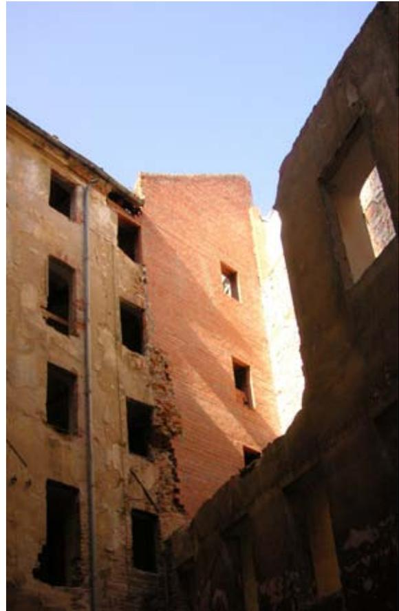
*Abbruchkante des eingestürzten Seitenhauses Nr. 10 (links), abgebrochene Decken und Wände zur Herstellung von treppenartigen Terrassen am Hinterhaus Nr. 8 (rechts)*
