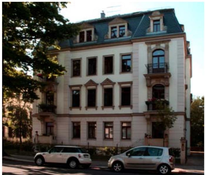
*Im Zuge der Sanierung wurde das erste und zweite Dachgeschoss vollständig abgebrochen und neu errichtet. Das Oberdach wurde dabei als Stahlkonstruktion ausgeführt.*
