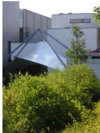
*Die Konstruktion der Innenhofüberdachung wird durch eine mit Seilen vorgespannte und an einem Stahlbock aufgehängte Hochpunktmembran mit trapezförmiger Grundrissfläche gebildet.*
