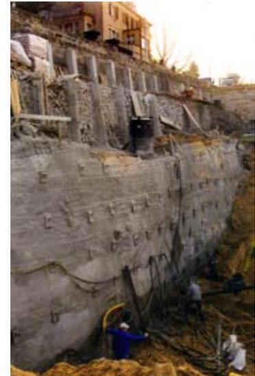
*Gelände unterhalb des Veilchenweges: mit Dauerbodennägeln verstärkte Natursteinstützmauern zur Hangsicherung, mittels temporärer Bodenvernagelung rückverankerte Spritzbetonschale als Baugruben- und Hangsicherung*
