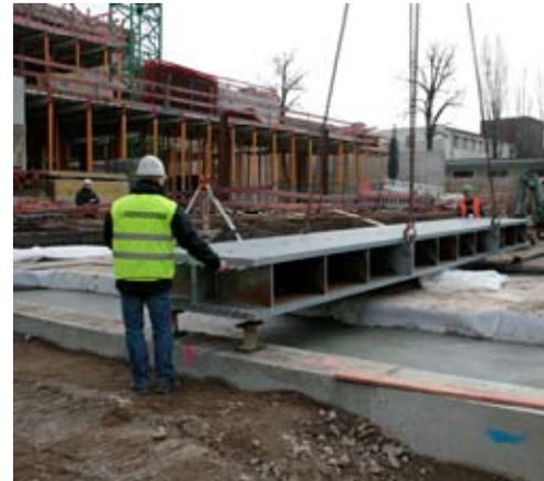
*Einbau eines geschweißten Stahlträgers mit angeschweißter Anschlussbewehrung in die über einen Medienkanal führende Bodenplatte zur Abfangung einer hochbelasteten Stahlbetonstütze*
