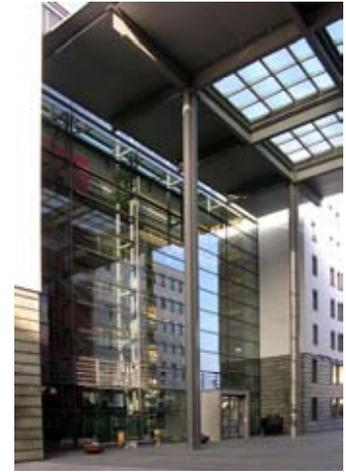
Spezielle Anforderungen an den Brandschutz der tragenden Bauteile sowie die Stabilisierung der äußerst schlanken Halbrahmen der Fassadenkonstruktion (linkes Bild, Quelle: Staatshochbauamt) wurden auf Initiative des Prüfenieurs im Zusammenspiel aller Beteiligten geklärt. Die freistehende, teilweise verglaste Überdachung des Ministerialplatzes wird durch ein Stahlträgerrost auf vier Stahlstützen gebildet (mittleres und rechtes Bild).
