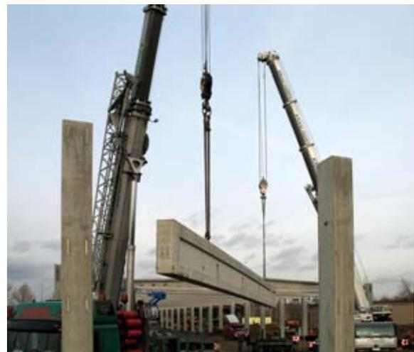
*Straßenbahnbetriebshof Reick: Montage der Stahlbetonbinder und Spannbeton-Satteldachbinder der zweischiffigen Abstellhalle (Quelle: DVB)*
