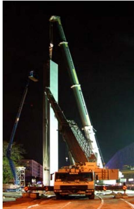
*Eintreffen des Pylons mit Ringquerschnitt am Einbauort (oben links)*
