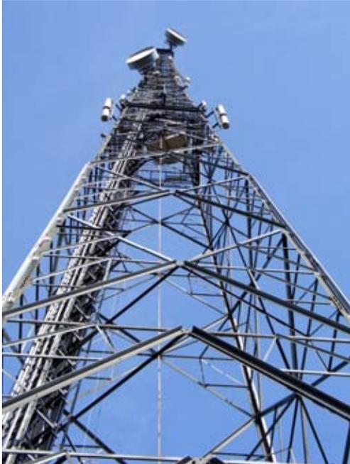
*Der vorhandene 75 m hohe Stahlgittermastturm erhielt eine neue Arbeitsbühne und wurde mit zusätzlichen Antennen bestückt. Diesbezüglich musste der Turm einschließlich der Gründungsbauteile verstärkt werden.*
