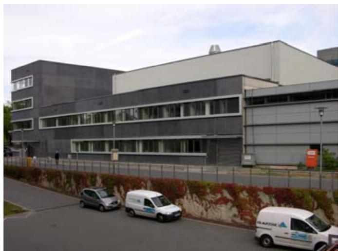
*Der mittlere Gebäudeteil mit aufgesetzter Technikzentrale (Stahlkonstruktion) schließt unmittelbar an das Bestandsgebäude Haus 60 (rechts im unteren Bild) an.*
