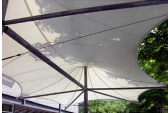
Die Tragkonstruktion der Überdachung besteht aus zwei seilverspannten Membranen aus PVC-Polyester-Gewebe, die an schirmartigen Stahlkonstruktionen befestigt sind.
