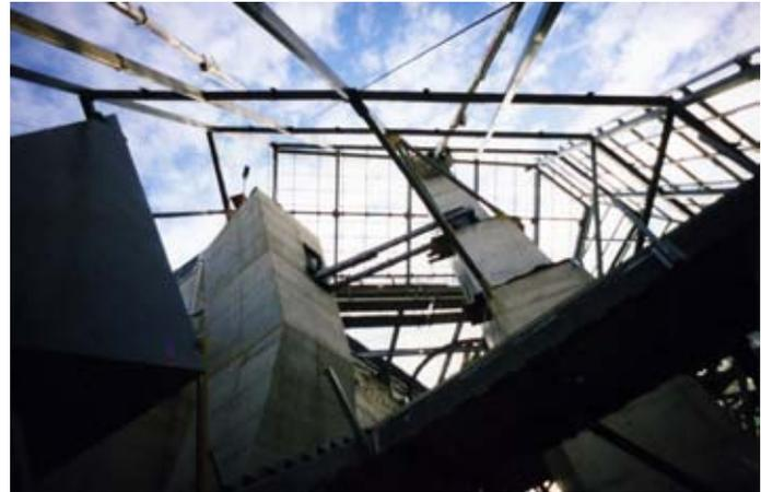
*Die z.T. abgehängte Stahlbau-Treppenanlage wird durch eine komplexe räumliche Tragstruktur gebildet.*
