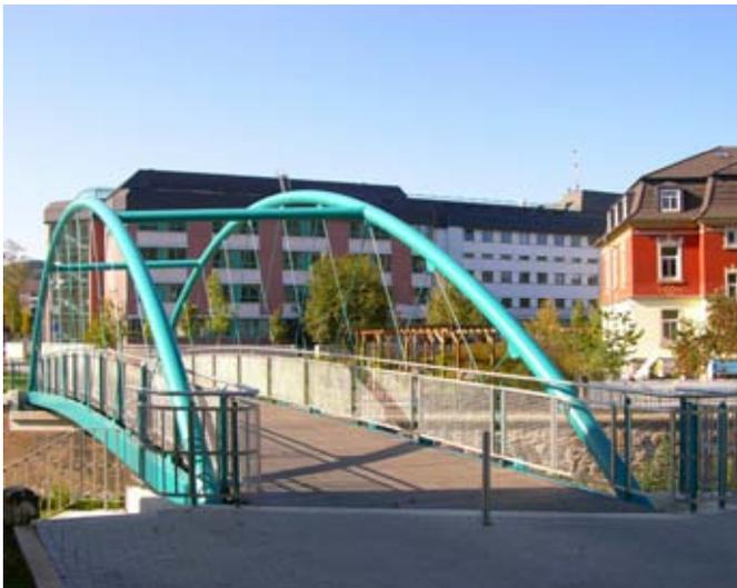
Die Fußgängerbrücke hat eine Spannweite von annähernd 26 m. Der Überbau wurde als geschweißte Konstruktion aus Stahlhohlprofilen hergestellt. Die Haupttragglieder bilden zwei senkrecht stehende Kreisbögen mit jeweils einem Hauptträger des Gehbahnträgerrostes als Zugband und einer Verspannung in der Bogenebene durch gekreuzt angeordnete Hänger.
