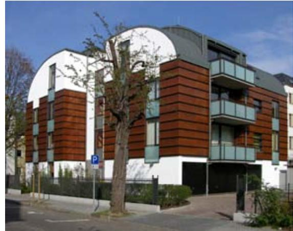
*Ansicht des Gebäudes mit einer Dachkonstruktion aus gekrümmten Brettschichtholz-Bindern und einer Fassadenbekleidung aus Holzwerkstoffplatten*
