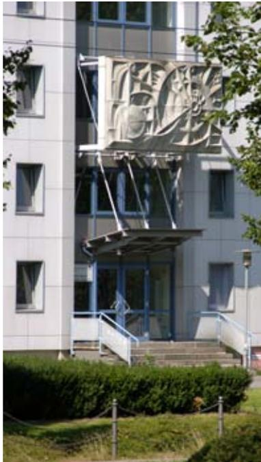
*Zur Aufnahme der Reliefs, die Bestandteil der ursprünglichen Fassade waren, dienen vorgehängte Stahlprofil-Rahmenkonstruktionen.*
