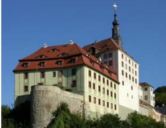
Die Stützmauer am Söller aus Bruchsteinmauerwerk mit einer maximalen Höhe von 12 m wies zum großen Teil offene Fugen, Risse und Deformationen auf. Im Bereich des hohen, halbkreisförmigen Wandabschnitts wurde das Mauerwerk vernadelt und mit Litzenankern im vorhandenen Fels verankert.
