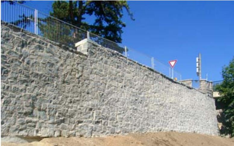
Die vorhandene Naturstein-Schwerkriegtsstützwand war stark geschädigt und z.T. bereits eingestürzt. Eine Rekonstruktion und Verstärkung war aufgrund des sehr schlechten Zustands als ungeeignet angesehen worden. Daher wurde eine mit Verpresspfählen rückverankerte Stahlbetonwand als Ersatzneubau errichtet. Die Stahlbetonwand als Fortsetzung einer Flügelwand der Friedensbrücke erhielt ein Verblendmauerwerk aus Granit.
