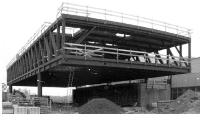
*In den Gurtebenen der Stahlfachwerke sind die Verbunddecken des Büroteils angeordnet. Die in Höhe des ersten Obergeschosses des Büroteils angeordneten Fachwerke lagern auf Stahlstützen auf. Im Bereich des Verbindungsbaus ruhen die Stützen auf dessen Giebelwänden.*
