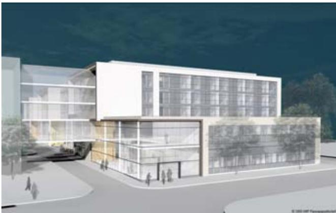
*Der Baukörper gliedert sich oberirdisch in einen Gebäudelängsriegel (Länge: 171 m) mit bis zu 5 Geschossen sowie in nach Süden hin orientierte Gebäudequerriegel (Länge: 45 m), deren Geschosszahlen alternierend zwischen 2 und 5 wechseln. Der Untergeschossbaukörper ist als „Weiße Wanne“ ohne Dehnfugen ausgeführt worden.*
