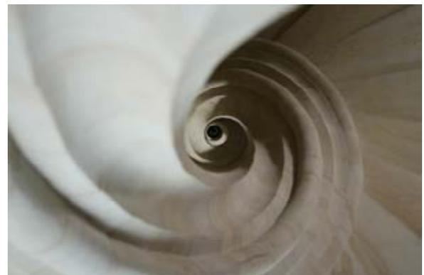
Treppenturm Nordost: Neubau der Treppe aus Sandsteinstufen: Die Stufen sind im Treppenauge aufeinandergelegt und bilden eine spiralförmige Stütze.
