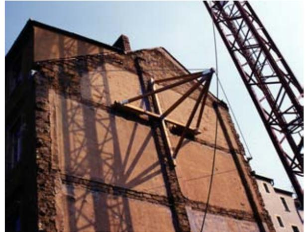
*Aussteifungskreuze als temporäre Notsicherung der Giebelwand (oben rechts)*
