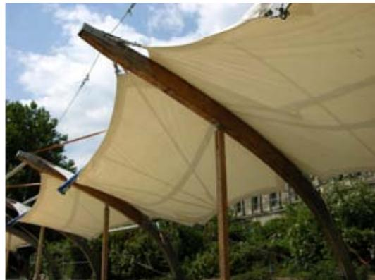
Die Konstruktion der Überdachung besteht im Wesentlichen aus gekrümmten Brettschichtbindern und mit Seilen sowie Druckstäben verspannten Membranen.
