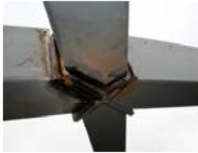
*In den Gitternetzknotten wurden die Stäbe unter Verwendung von Stahlblechkreuzen biegesteif miteinander verschweißt. Mit Hilfe dieser Kreuze war es möglich, Profilstäbe mit sich gegenüberliegenden ungleichen Schnittflächen zusammenzufügen.*
