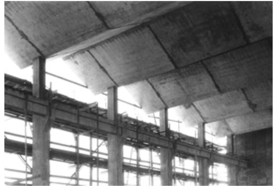
Die Ertüchtigung des aus zusammengespannten Fertigteilsegmenten bestehenden Faltdachdaches erfolgte bei laufendem Betrieb in der Versuchshalle mit auf der Dachinnenfläche aufgeklebten Stahllamellen.
