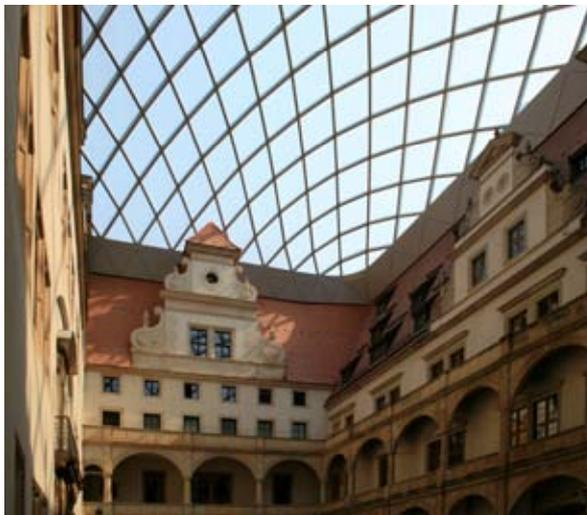
*Die Transparenz der Überdachung wird durch den Einsatz von luftgefüllten ETFE-Folienkissen erreicht, die extrem leicht sind und sich gut an die windschiefe Geometrie der rautenartigen Felder anpassen.*
