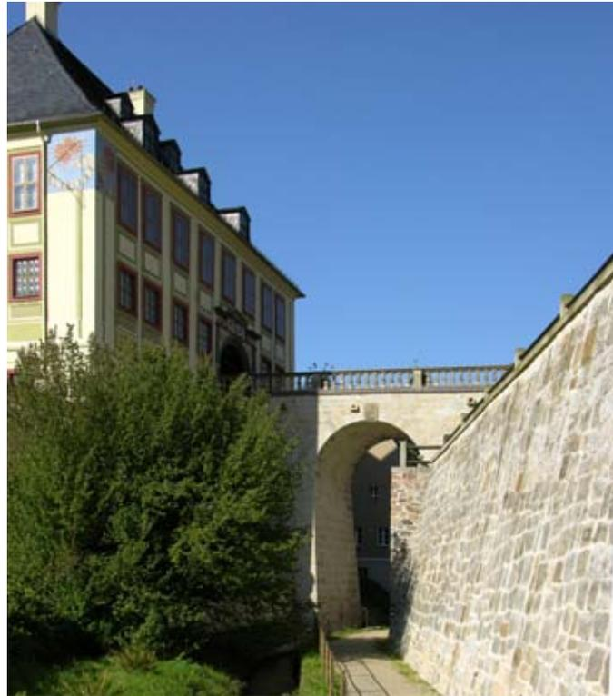
Die Baumaßnahmen betrafen auch die Instandsetzung und die Verstärkung der über den Mühlgraben führenden Hauptbrücke einschließlich der Widerlager und der Flügelwände. Im Hinblick auf die Gewährleistung der erforderlichen Standsicherheit wurden die betreffenden Bauteile aus Natursteinmauerwerk rückverankert. Die Rückverankerung erfolgte mit Dauerankern im anstehenden Fels bzw. mit Dauerbodennägeln im Lockergestein.
